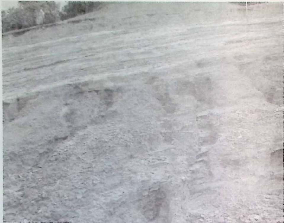
c. Contoh 3 lapisan batuan yang sudah mengalami pelapukan ( weathering )
